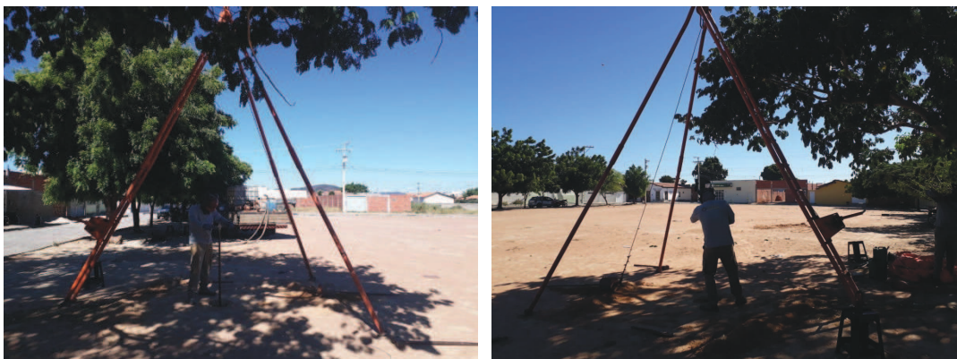
Foto 10 e foto 11: Furo SP-03
