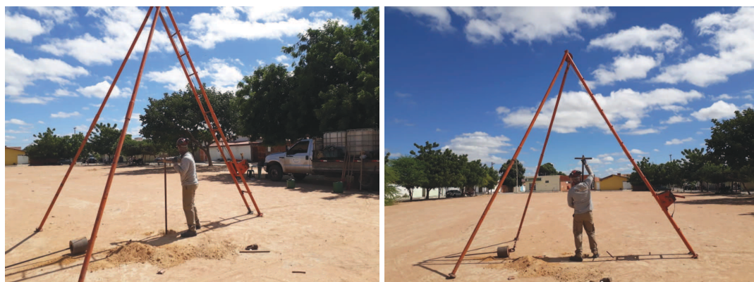
Foto 13 e foto 14: Furo SP-04
