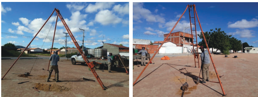
Foto 29 e foto 30: Furo SP-08
