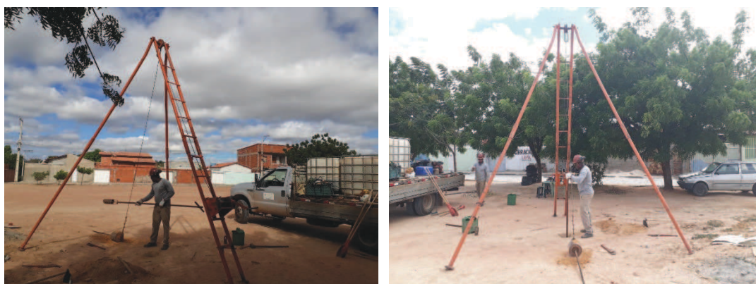
Foto 26 e foto 27: Furo SP-07
