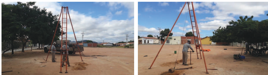
Foto 01 e foto 02: Furo SP-01.
