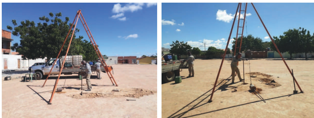
Foto 16 e foto 17: Furo SP-05
