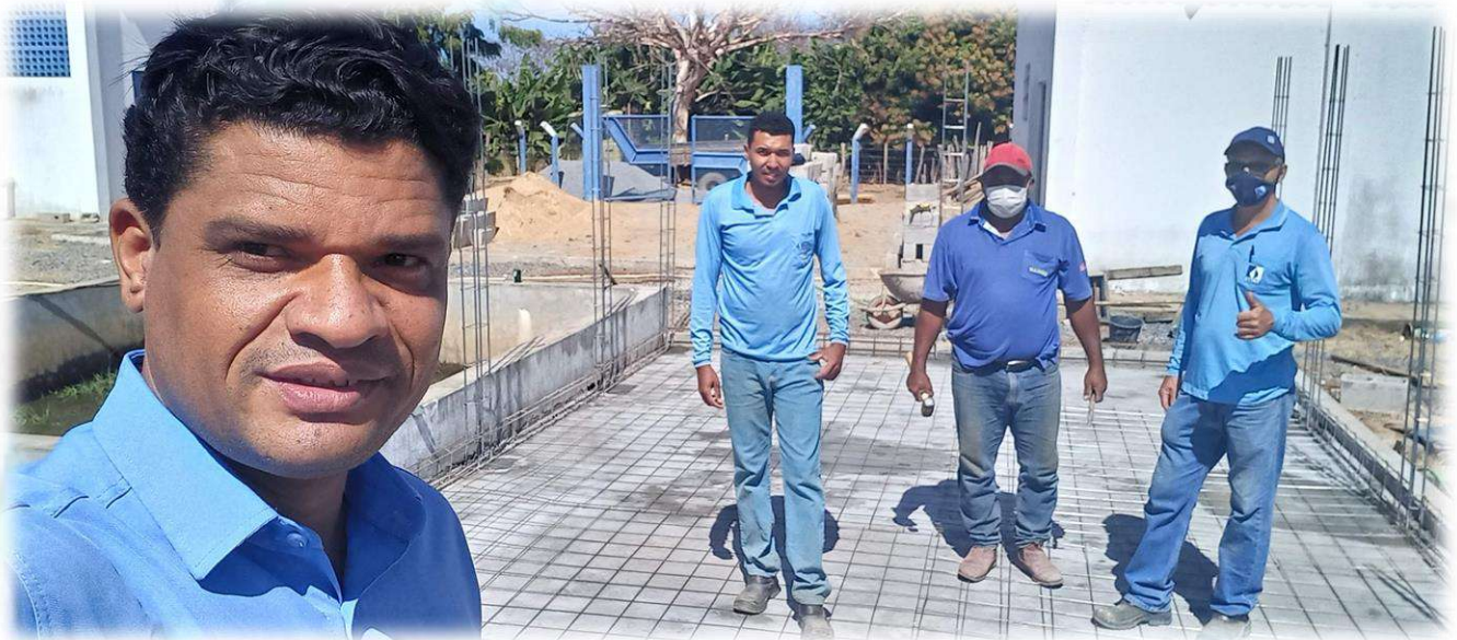
Ampliação do Sistema do Sistema de Abastecimento - Zona Rural ETA do Retiro - Quilombo Araçá – Volta - Bom Jesus da Lapa-BA
