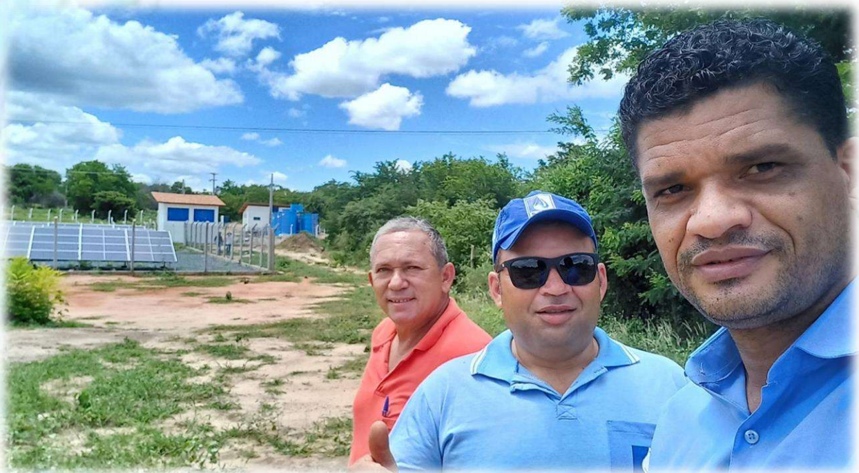
Estação Tratamento de Água do Projeto Formoso
