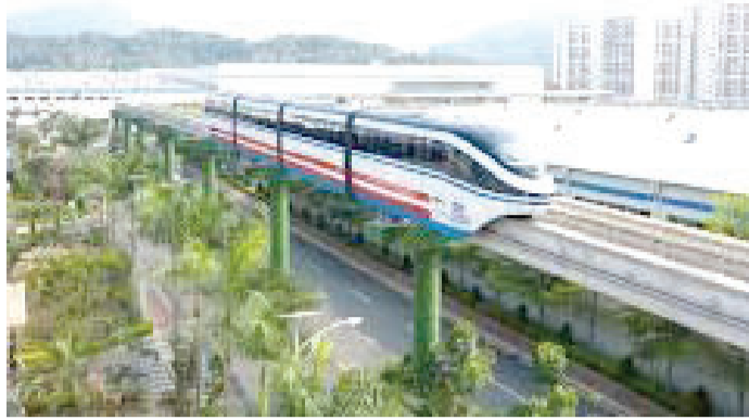
MOBILIDADE Via ferroviária da Calçada será revitalizada para o VLT
