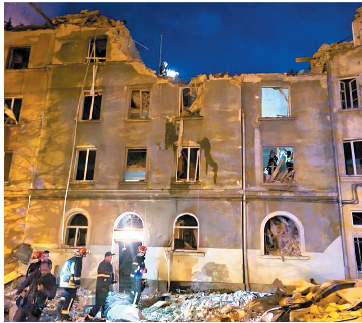
Prédio danificado após o bombardeio na cidade de Lviv, na Ucrânia
